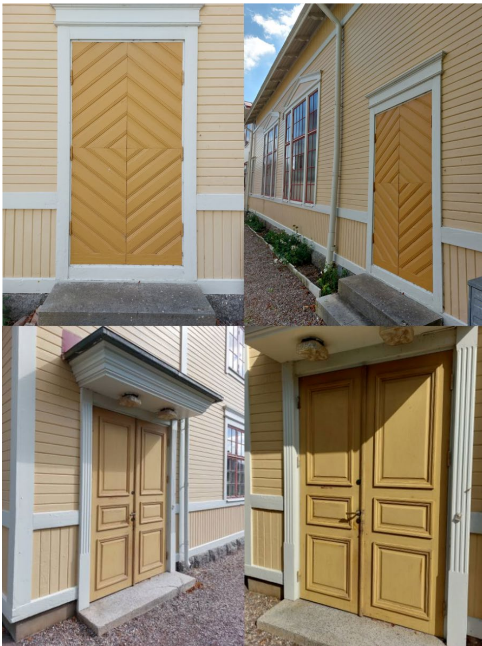
Figur 15: Bilderna visar äldre paneldörr med diagonal panel samt spegelpartittdörrar som skyddas med planbestämmelserna q_2 och k_1 .
