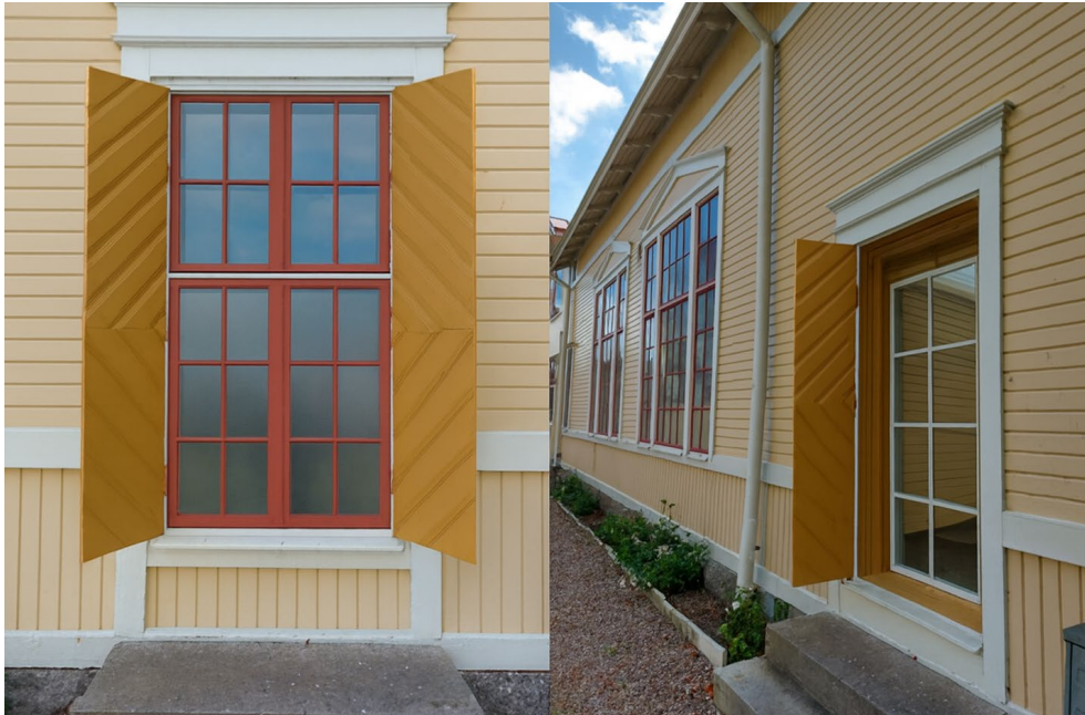
Figur 20: Förslag på anpassning av befintlig pardörr med infogat fönsterparti för ökat ljusinsläpp. Åtgärden är reversibel och bevarar dörrens ursprungliga karaktär. Jämför med Figur 15 som visar entréns nuvarande skick.
