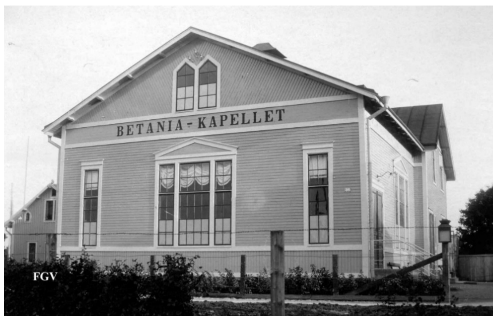
Figur 11: Betania-kapellet – okänt årtal före om- och tillbyggnad. Källa: föreningen gamla Vadstena
