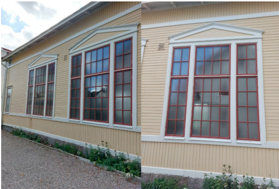
Figur 14: Bilden visar fönsterutformningen och den smårutiga spröjsade indelningen i trä och dess kapitälformade krön. Dessa skyddas med planbestämmelserna q_1 och k_1 .
