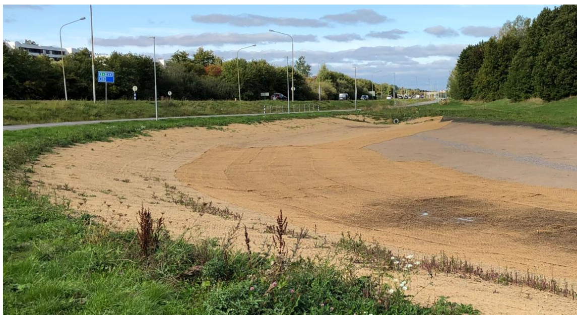
Figur 14 – Exempel på större torrdamm - dagvattenhantering för bostadsområde Skogsvallen i Linköping (Boberg 2020). Damm utförd med dränering i dammbotten samt erosionsskydd av typ kokosnät.
