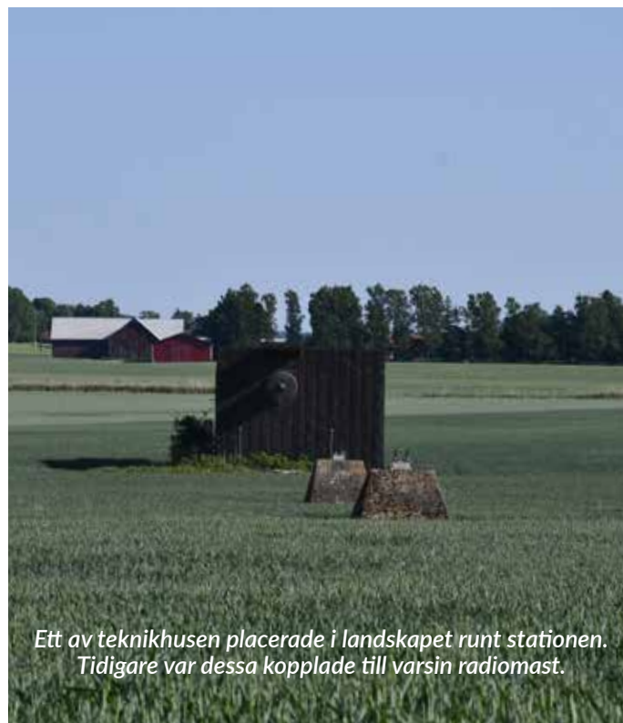
Rester efter den rasade masten.
